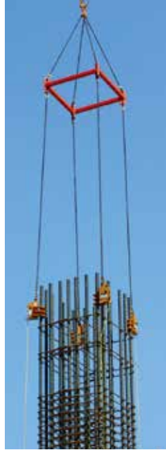
・柱吊天秤とクランプを使用して柱筋を安全確実に移動できます。
