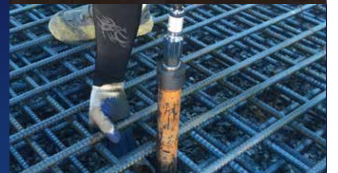
スペーサー手直し時のスラブ持ち上げ作業
