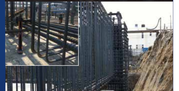
スタラップ配筋時の下筋の持ち上げに
