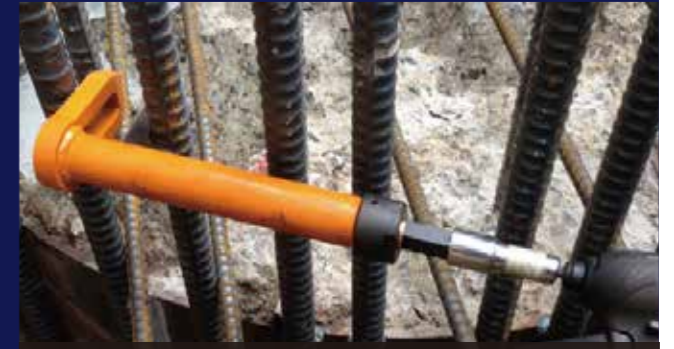
杭頭筋へベース筋を通す作業に
